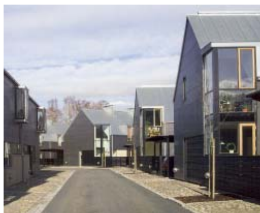
Bebyggelse ved Viken i Sverige. Husene ligger med gavl ud mod gaden, og har markante høje vindueskarnapper, der sammen med de mørke facader og de lyse zinktage er bebyggelsens særkende.
