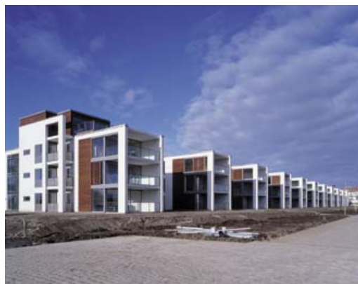
Boliger ved langelinie i Horsens. Bebyggelsen ligger i tilknytning til lystbådehavnen. Alle boliger har adgang til lys, luft og udsigt. Bebyggelsen er udformet som en smal ryg mod landsiden, mens facaden mod vandsiden er udformet som karnapper.
